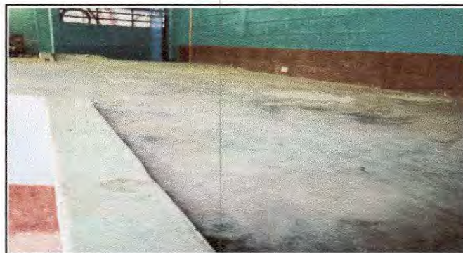
Foto 4: SUSTITUCION DE PISO DE TORTA DE CONCRETO
