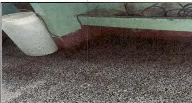
Foto 10: MANTENIMIENTO A REPOSADERAS (tapaderas quebradas y extraviadas)
