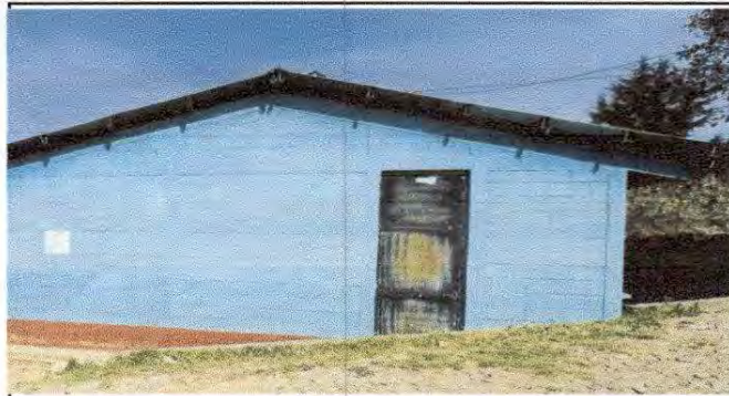
Foto 2: MANTENIMIENTO DE ESTRUCTURA (lijado y aplicación de pintura)
