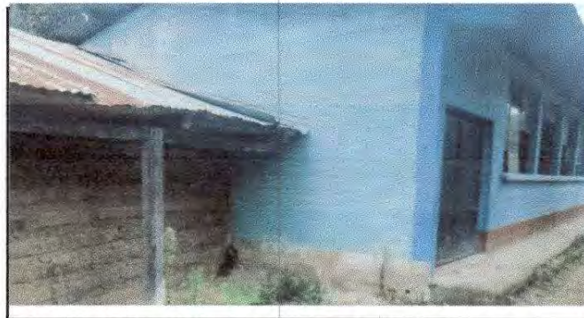
Foto 6: PINTURAS EN MUROS EXTERIORES E INTERIORES
