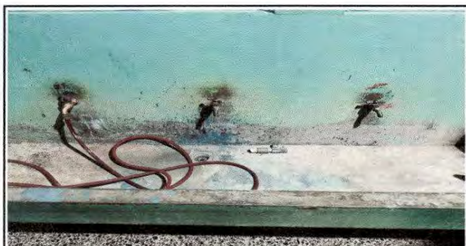
Foto 9: SUSTITUCION DE MEZCLADORA LAVAMANOS (CONTRA LLAVE, TUBO DE ABASTO) Y MINGITORIOS
