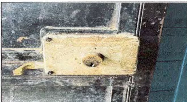
Foto 3: SUSTITUCION DE CHAPA
