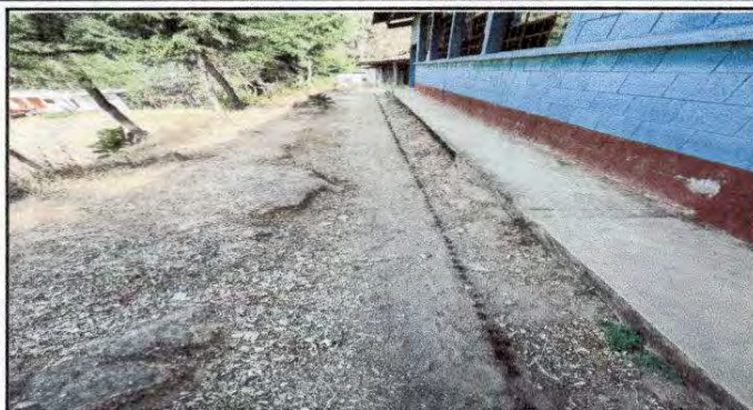
Foto7: PINTURA EN MUROS EXTERIORES E INTERIORES
