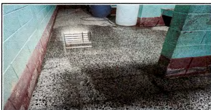
Foto 11: REPARACION DE RED DE DRENAJE (tuberia dañada sistema de drenaje aguas negras fuga bajo el piso)
