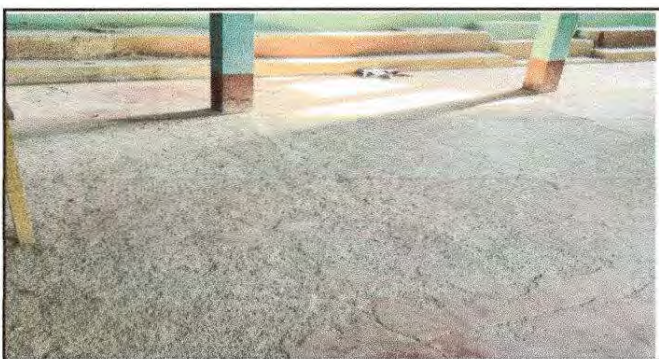
Foto 5: SUSTITUCION DE PISO DE CEMENTO LIQUIDO
