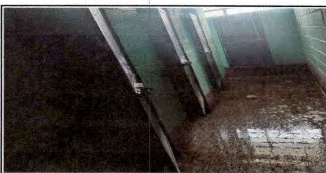
Foto 12: REPARACION DE RED DE AGUA POTABLE (tuberia PVC dañada fuga de agua bajo el piso)
